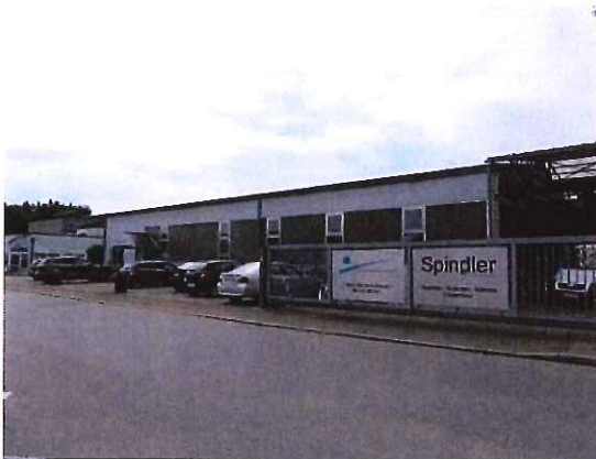
Maschinenbau / Stahlbau im Süden
