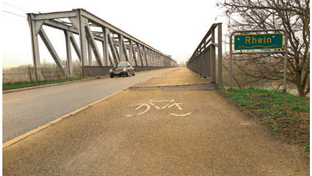
Der Rad- und Fußweg über den Rhein hinweg soll breiter und sicherer werden
