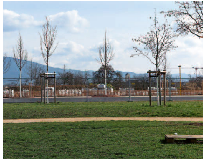
Die Baumaßnahmen für das Freigelände der Landesgartenschau 2022 schreiten planmäßig voran. 95 Prozent der Ausschreibungen sind vergeben.
