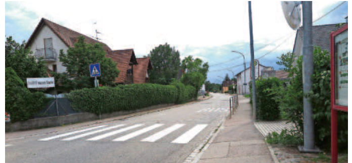
Auch die Ortsdurchfahrt Zienken wird saniert und mit einem lärmreduzierenden Belag versehen.
