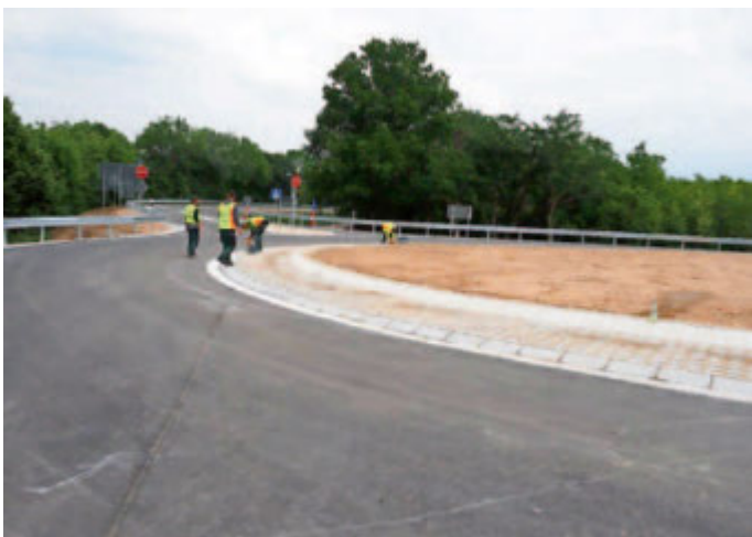
Allerletzte Handgriffe vor der Eröffnung des ersten Kreisverkehrs.
