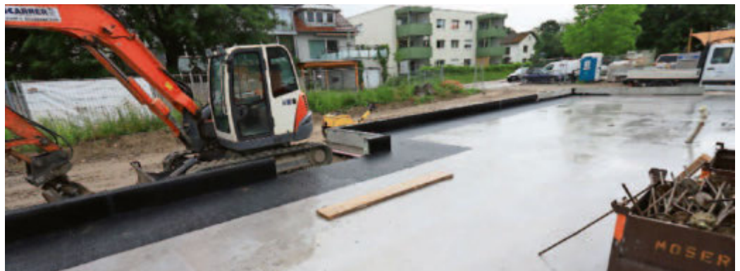
Abdichtung der Bodendeckplatte mit Bitumen
