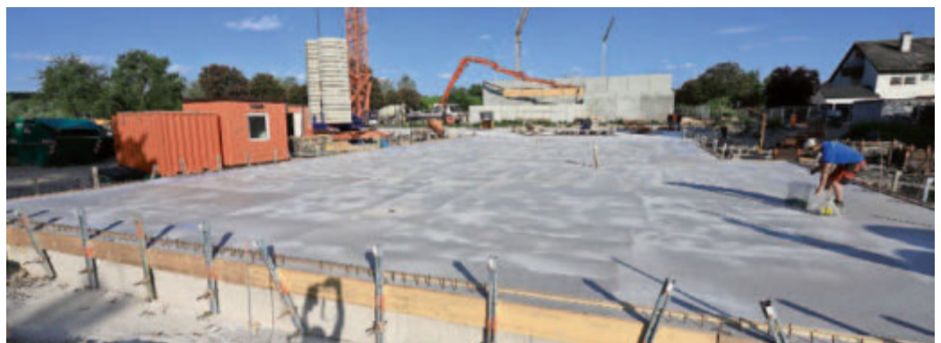
Die Kita am Wuhrloch ist teilunterkellert und die komplette Bodenplatte bereits fertig.
