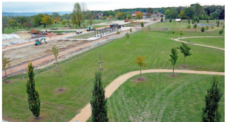
Das Gelände nimmt mehr und mehr Gestalt an, auch die Arbeiten an der Rheinterrasse schreiten zügig voran.
