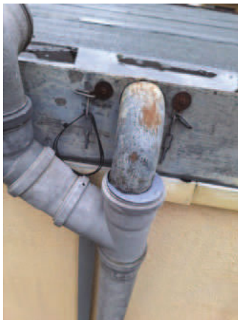
Fallrohre abdichten
