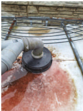
IBC-Container mittels Deckel schließen
