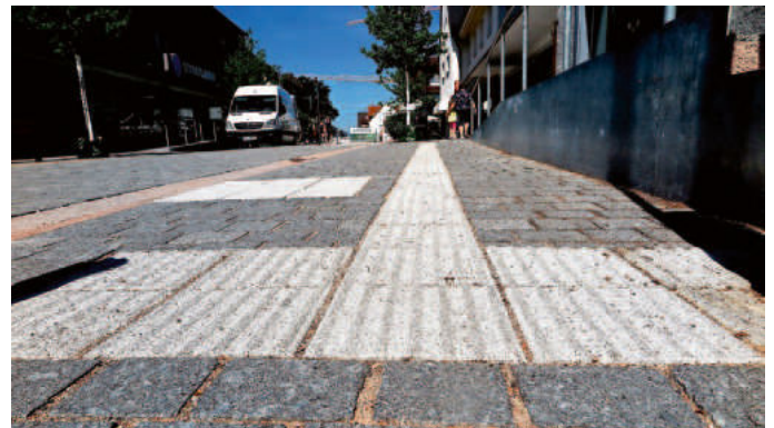
Neben der taktilen Wahrnehmung des Leitsystems ist auch der farbliche Kontrast zum umgebenden Straßenbelag für Sehbehinderte eine wichtige Hilfe.
