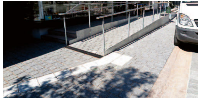
An der Rampe endet die Leitlinie mit den Rillen in einem Aufmerksamkeitsfeld. Die Rampe selbst ist parallel zur Laufrichtung von zwei Stahlkanten begrenzt.
